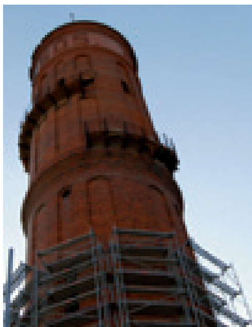
La torre de les aigües es troba en obres de rehabilitació
