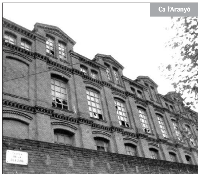
Obres del Pla Campus Audiovisual a Ca l'Aranyó.
