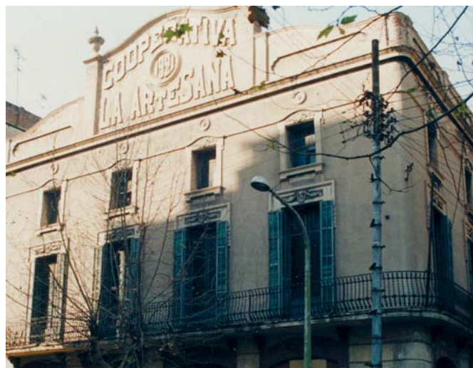
Edifici de la cooperativa La Artesana, avui desaparegut, al carrer de Llull amb Marià Aguiló
