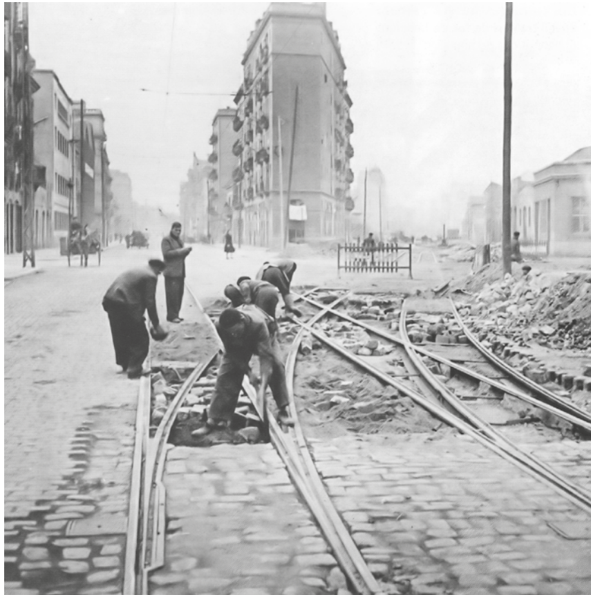
Obres del tramvia a la cruïlla de Pere IV i Pallars (Arxiu Històric del Poblenou)
