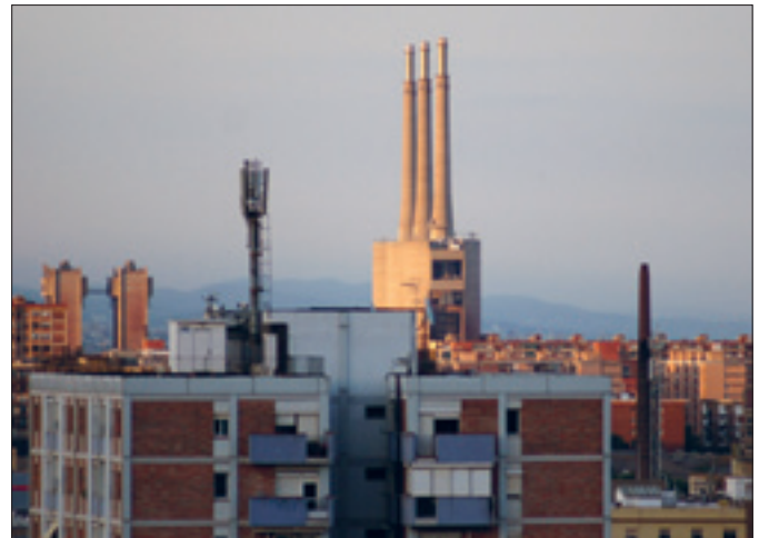
Les tres xemeneies de la tèrmica del Besòs, incorporades al paisatge de la ciutat, resten ara inactives. La central ha estat substituïda per noves instal·lacions de generació com la planta processadora de residus TERSA, que a més de generar electricitat proporciona calefacció centralitzada (district heating) al 22@, i per diversos grups de cycle combinat alimentats per gas natural.
