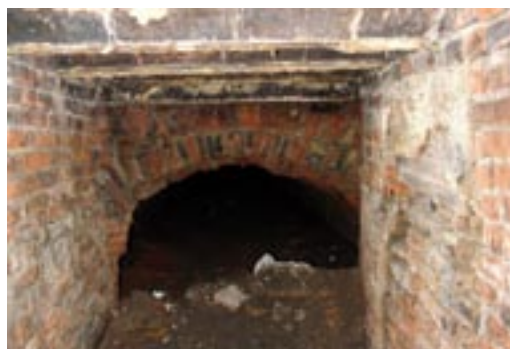
Instal·lacions tècniques al subsòl de Can Ricart
