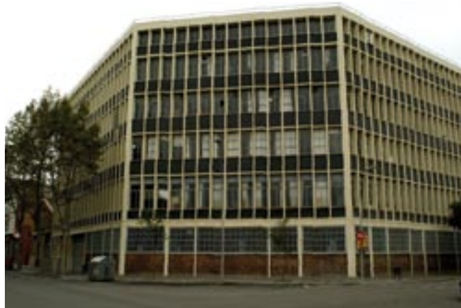
Edifici industrial que ocupa l'empresa Simon al carrer Sancho d'Àvila.
