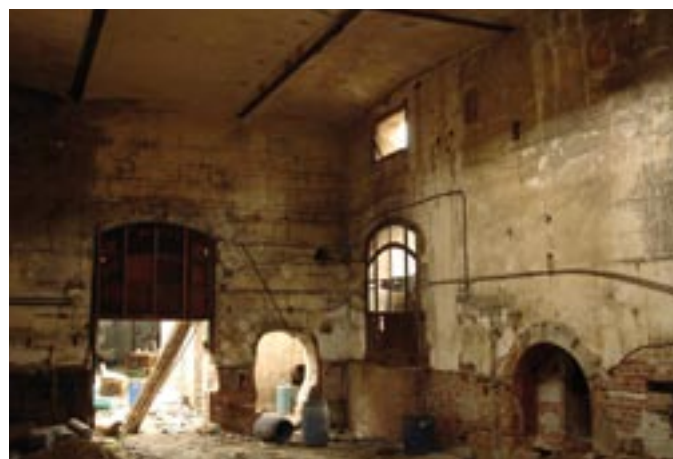
Estat actual de l'interior de la sala de la màquina de vapor de Can Ricart.
