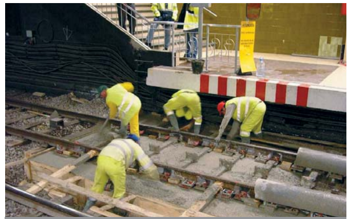
Obres de reforma a la via de la L4
