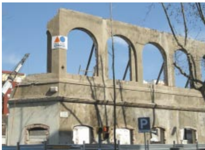
La façana que ha quedat d'empeus d'esprés d'enderrocar la resta de l'edifici.
