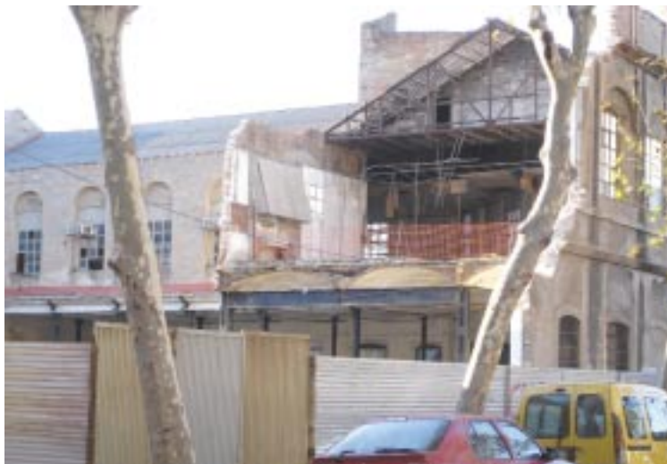
Part de l'edifici del Cànem que es mantindrà i rehabilitarà al carrer Llacuna
