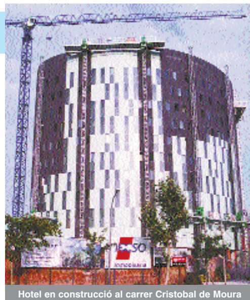
Hotel en construcció al carrer Cristobal de Moura
