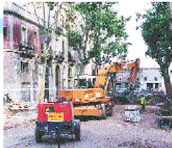
Ja han començat les obres del pla d'infraestructures al carrer de Llacuna
