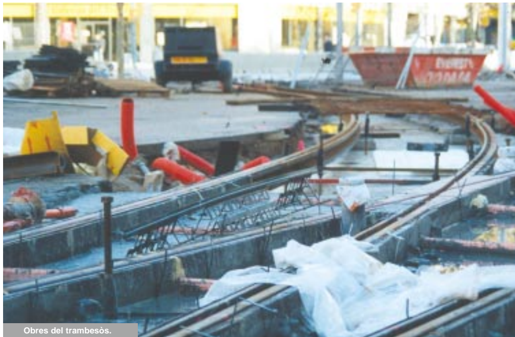
Obres del trambesòs.
