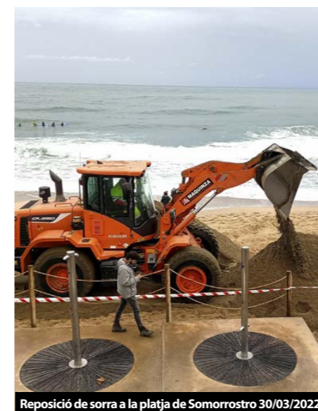
Reposició de sorra a la platja de Somorrostro 30/03/2022
